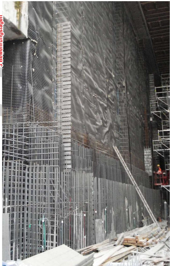
safeform 03089 WA Streckgitter-Dichtleiste in Kombination mit TRIGOFORM® Abschalssystem perfekt
